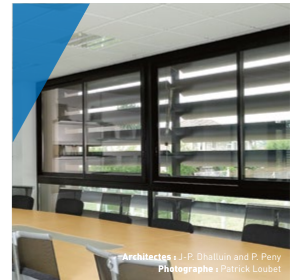
Lames de 300 mm motorisées - Inclinaison 45°
